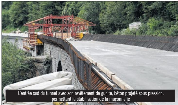
L'entrée sud du tunnel avec son revêtement de gunite, béton projeté sous pression, permettant la stabilisation de la maçonnerie
