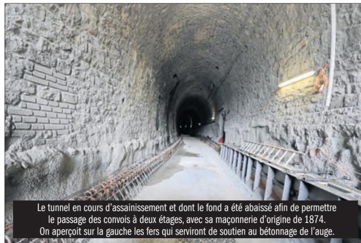
Le tunnel en cours d'assainissement et dont le fond a été abaissé afin de permettre le passage des convois à deux étages, avec sa maçonnerie d'origine de 1874. On aperçoit sur la gauche les fers qui serviront de soutien au bétonnage de l'auge.
