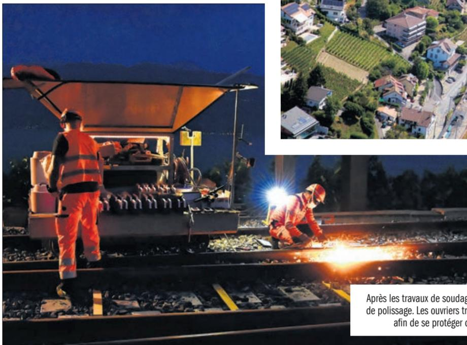
Après les travaux de soudage des rails, la délicate opération de polissage. Les ouvriers travaillent sous masque à oxygène afin de se protéger des émanations de fumée
