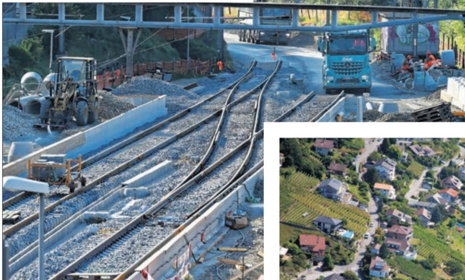
En gare de Grandvaux, à proximité de l'entrée du tunnel, les rails sont assemblés et soudés grâce à un procédé spécial
