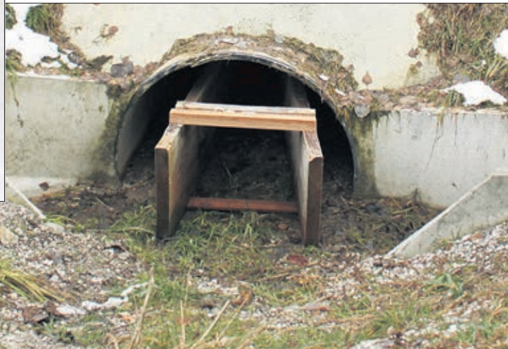
Passage d'entrée sous la route avec le déflecteur en bois
